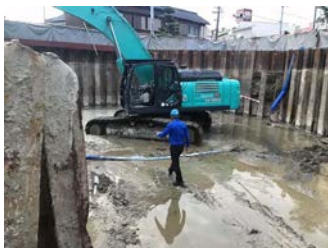
改良された土壌の上を足が取られる ことなく歩行可能。
