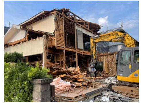
木造家屋解体工事
