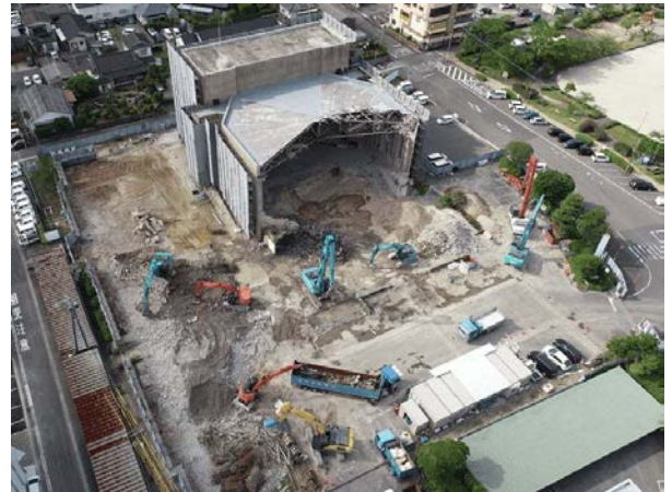
大規模公共ホール解体工事
