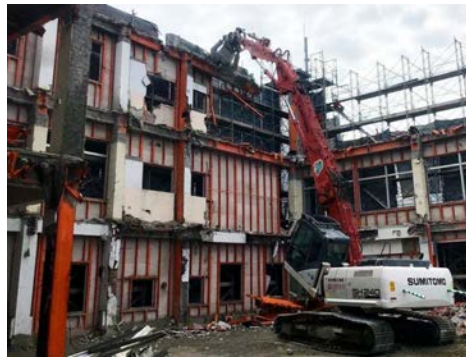
鉄骨建屋解体工事
