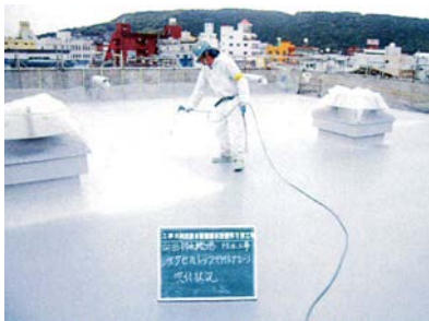
屋上防水改修工事
