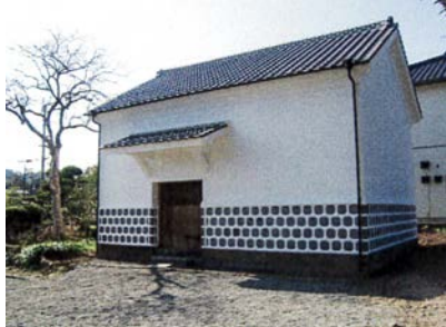
文化財建物改修工事（完成）
