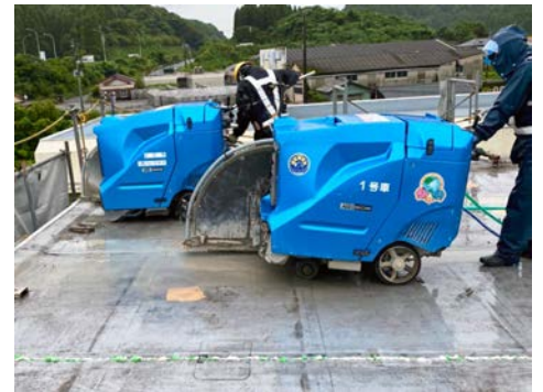
ロードカッターによるコンクリート切断
