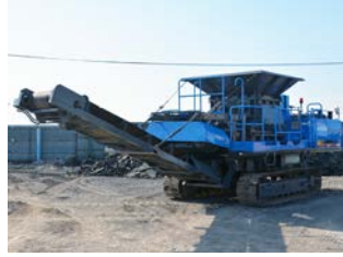
現場内コンから小割破碎作業用重機
