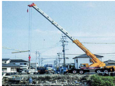
ワイヤーソー及びクレーンによる 橋台撤去
