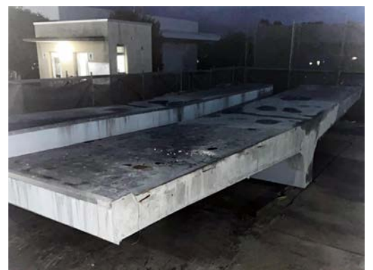
高速道路の料金所（トールゲート）の大型コンクリート屋根の切断状況
