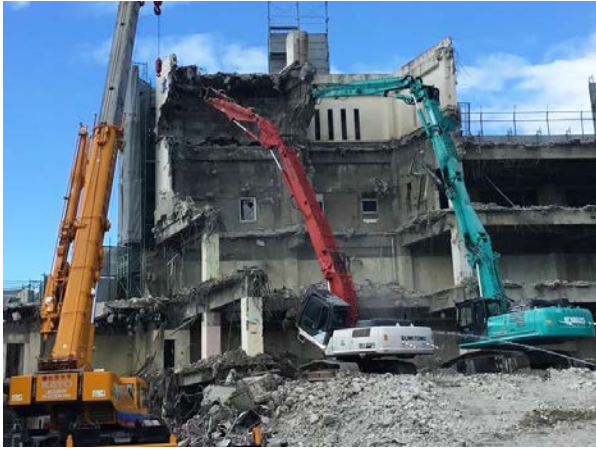
大型商業施設解体工事
