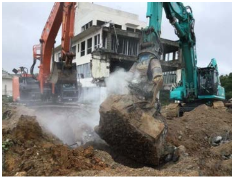
公共宿舎施設基礎撤去状況
