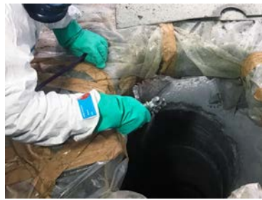
煙突の石綿断熱材除去作業状況
