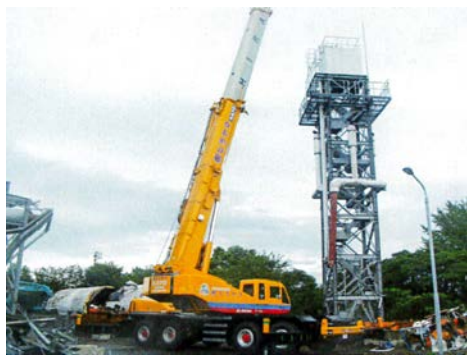
自社75tラフタークレーンによる 高架タンク撤去
