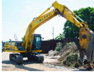
現場内木材小割破碎作業用重機
