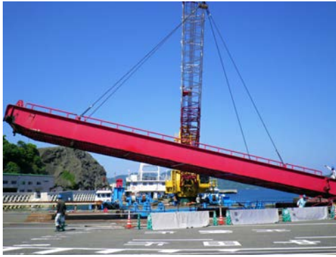
大型栈橋撤去作業 (クレーン船との共同施工)
