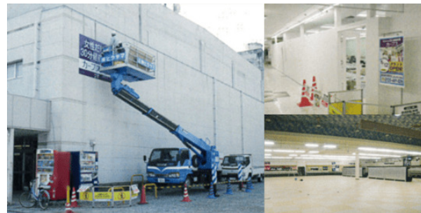
大型商業施設改修工事
