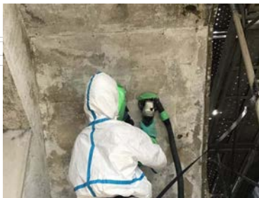
石綿含有塗材剥ぎ取り状況
