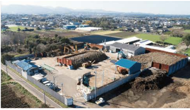
第一上水流リサイクル処理施設
